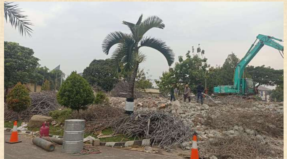
PROSES PEMBANGUNAN GEDUNG KANTOR POLDA JABAR
